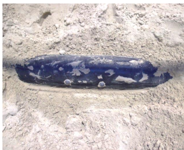
Figur 10. Ny brystblanke i Ø 160 mm plastrør, monteret direkte på betonkanten og 1,80 m fra bagkanten.
