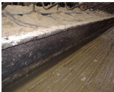
Figur 9. Påboltet bagkant på 17 cm, gør bagkanten i alt 37 cm høj.
