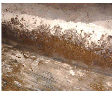
Figur 3. Ny bagkant af 100 x 200 mm tømmer med afrundet top monteret direkte på gulvet med kraftige galvaniserede vinkelbeslag.
